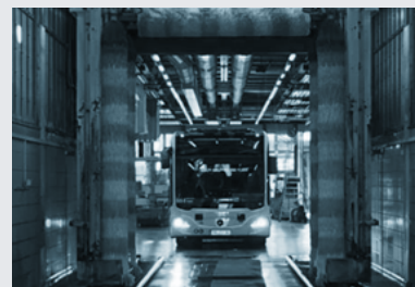
Automatisierter Betriebshof Stuttgarter Straßenbahnen
